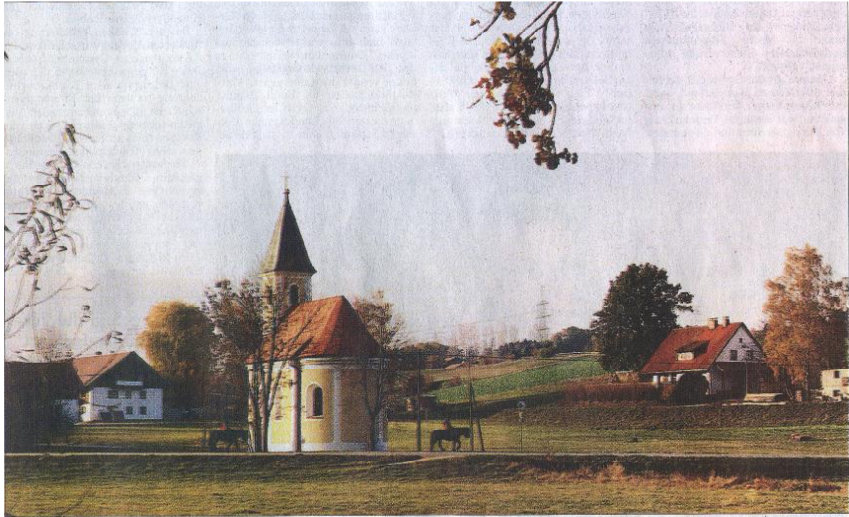
DAS ST. ANDREASKIRCHLEIN IM WEILER HARSKIRCHEN bei Adlkofen liegt an einer alten Straßenkreuzung im ehemaligen Rodungsgebiet des Kröninger Forstes. Harskirchen soll zwischen dem achten und zehnten Jahrhundert gegründet worden sein und war vor langer Zeit ein Adelssitz. Urkundlich genannt wird 1373 ein „Hartprecht der Harskirchner von Zangberg, herzoglicher Rath und Kammermeister“. 1416 starb diese Familie aus. Das jetzige barocke Kirchlein, ursprünglich mit Zwiebelturm, der später durch den Spitzhelm ersetzt wurde, ist vor 260 Jahren erbaut worden. Es ist dem heiligen Andreas geweiht, dessen Namensgedenktag der 30. November ist (Foto: Gretl Schratzenstaller)
